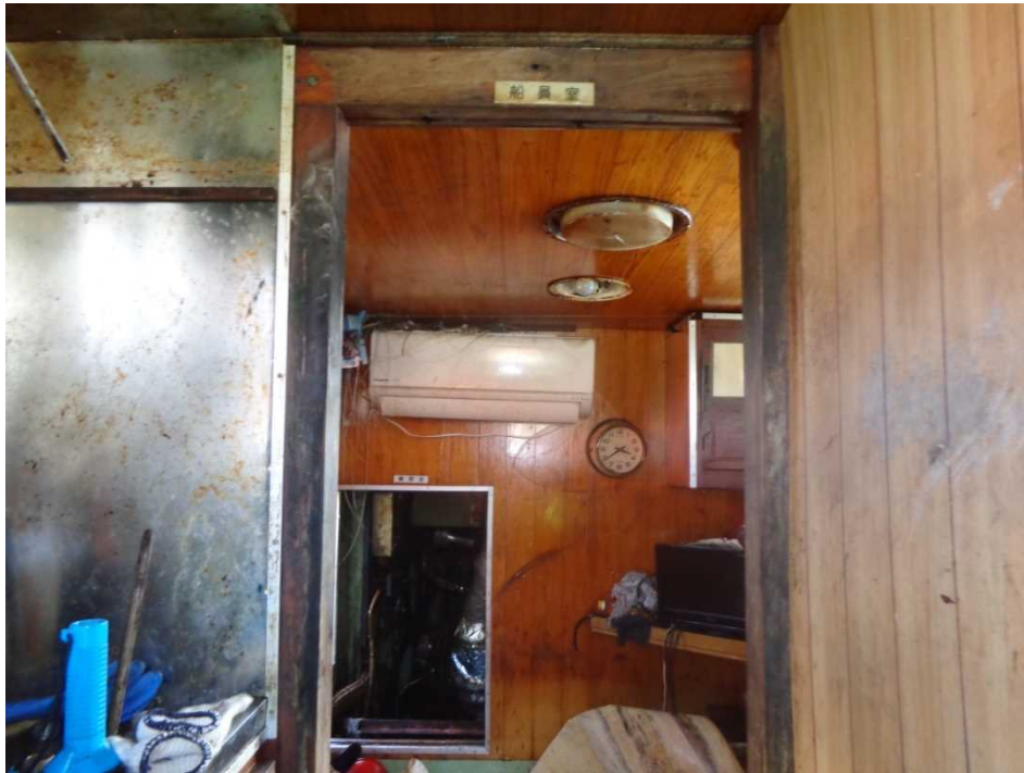
写真5 A船の船員室付近の状況
