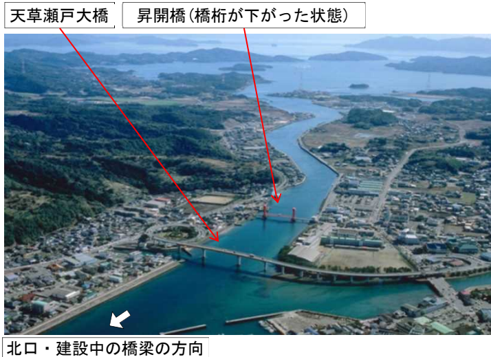
写真2 本渡瀬戸（国土交通省九州地方整備局熊本港湾・空港整備事務所 提供）
