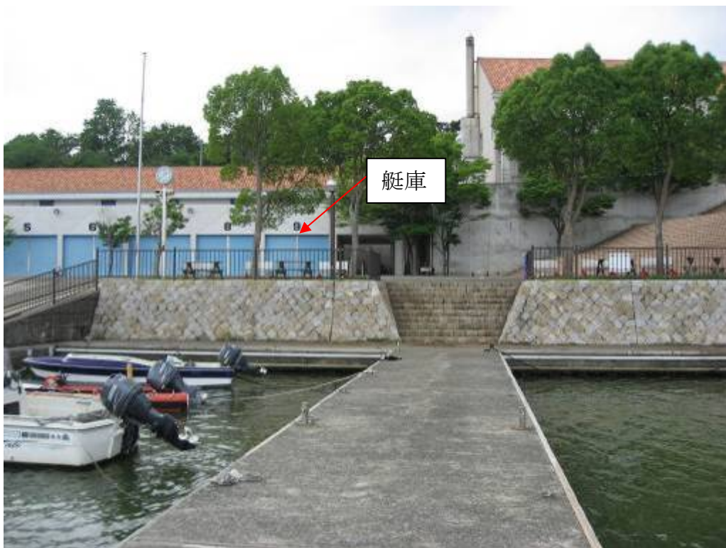
写真16 ハーバー（艇庫）の状況
