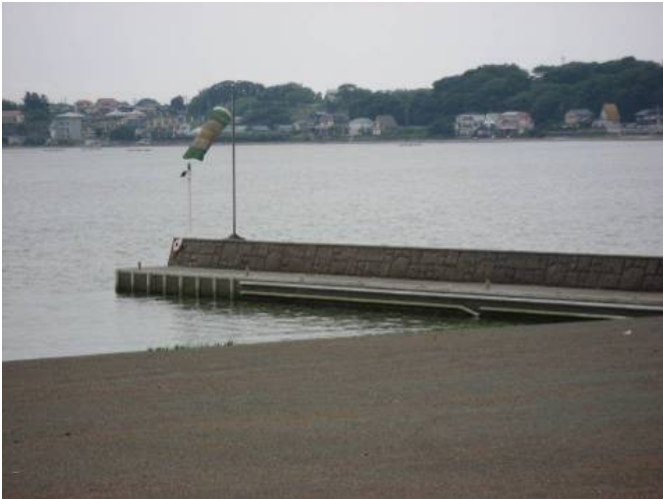
写真 2 1 吹き流しの状況
