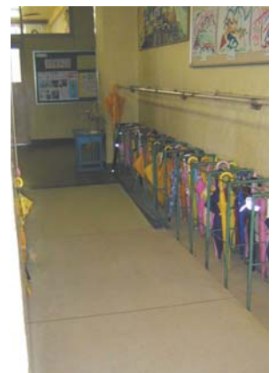
K 既存棟児童出入口 改修を行っていない既存棟についても児童出入口に傾斜路を設置している。
