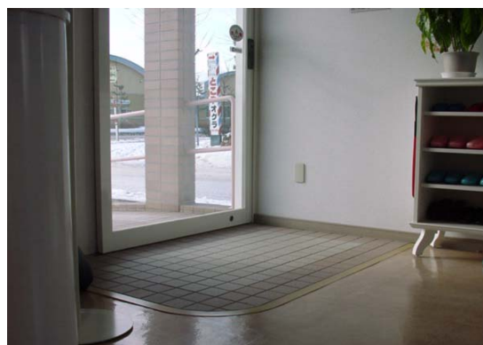
D 段差のない玄関踏込みまわり
