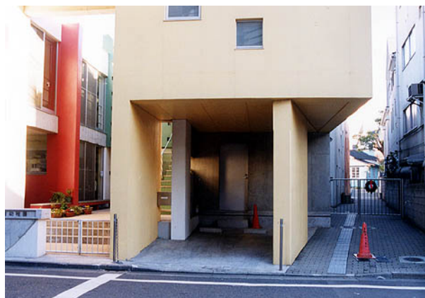
C 正面玄関横の障害者用通路
