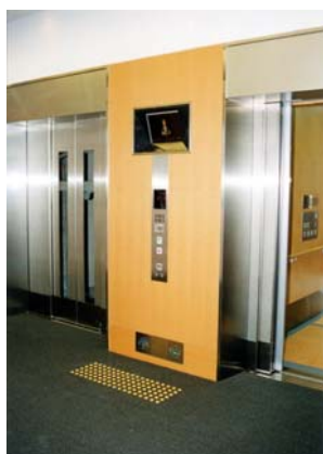
D エレベーター
