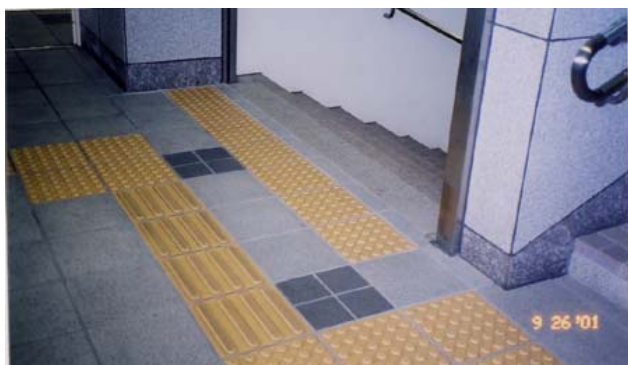
D 階段踊り場 廊下に接する踊り場に視覚障害者誘導用ブロックを敷設している。
