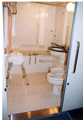
J 改修したユニットバス 傾斜路を設け、段差を解消。補助手すりの追加。洗面器下奥の確保。便器前スペースの確保。調節可能で軽量のシャワーヘッドに取替。水栓のシングルレバー化等の改良を行う。
