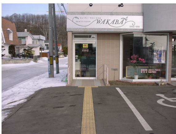
B 視覚障害者誘導用ブロックと車いす使用者用駐車スペース
