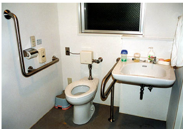
H 多機能便房 緊急呼び出しボタン、洗浄ボタン（自動・手動兼用）も装備している。
