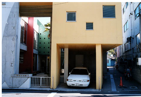
A 道路からの全景
