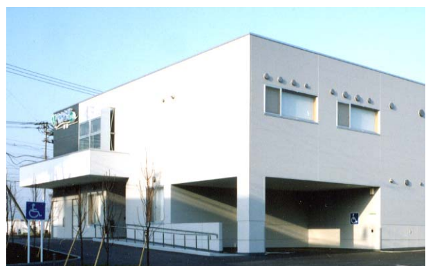
H 車いす使用者用駐車スペース 雨雪時を考慮した屋根が設置されている。
