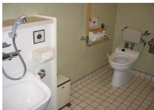
J 便所（オストメイト用汚物流しを設置）
