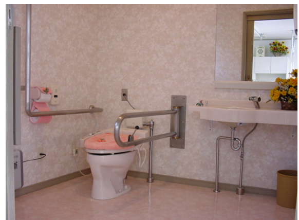
F 多機能便房 車いす使用者に配慮されている便房となっている。
