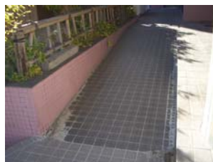
A 玄関前スロープ
