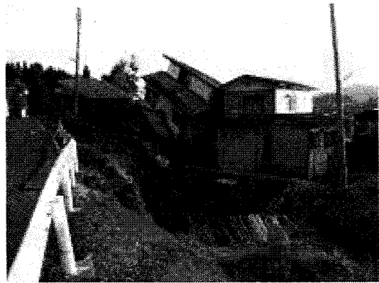
地盤崩壊に伴う住宅倒壊
