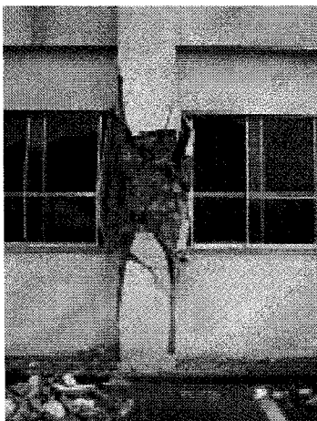
短柱のせん断破壊
