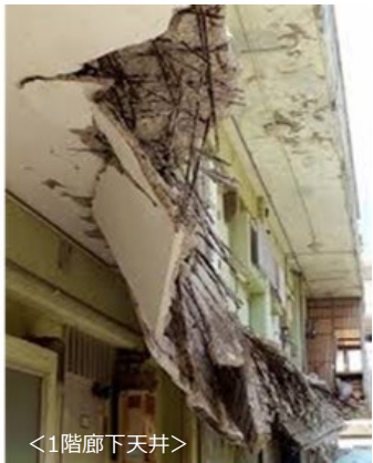
建物の傷みが著しく外壁の剥落、鉄骨の露出などが見られる事例
