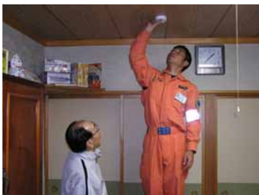
【火災警報器取り付けの様子】
