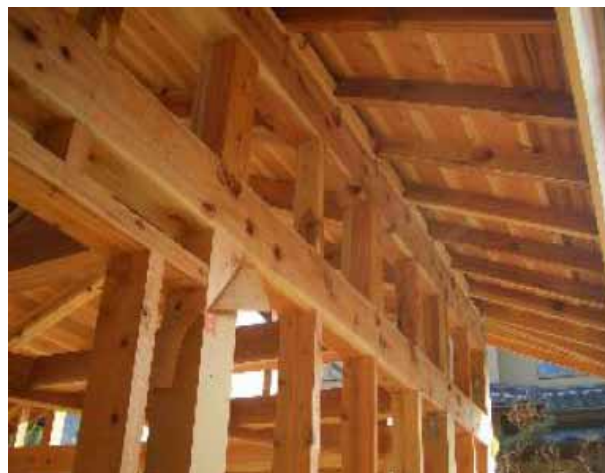
【びわ湖材を使用した住宅】
