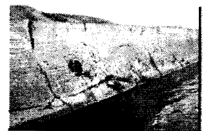
堤防の表法被覆工 が損傷
