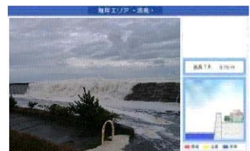
沿岸監視カメラ・越波情報提供システムの整備
