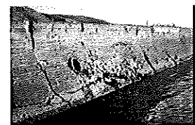
堤防の表法被覆工が損傷
