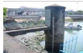
潮位計等の観測施設の整備
