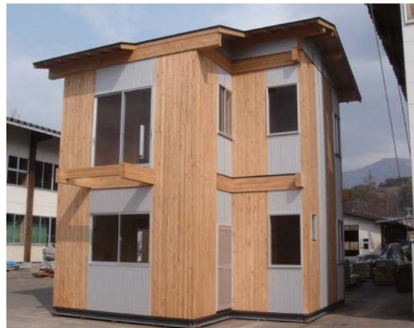
木造住宅用耐力壁パネルを用いたモデル試験棟
