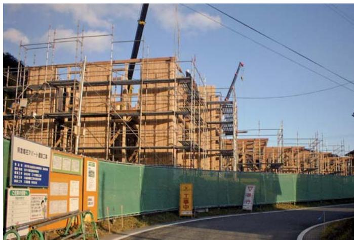
耐力壁パネル施工例 岩手県営住宅鳴石アパート新築工事
