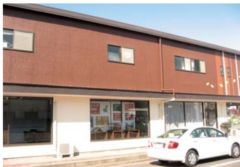
ショールーム機能も持った木材備蓄倉庫
