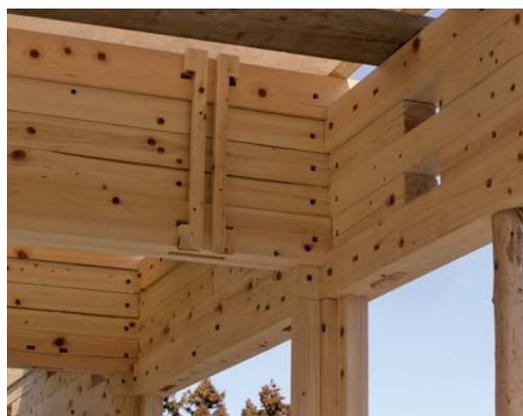
小径木の間伐材を木造建築物に利用する構法に取り組む
