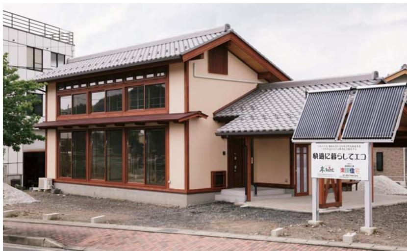
実際に建設した土塗り壁を用いた実験モデル住宅
