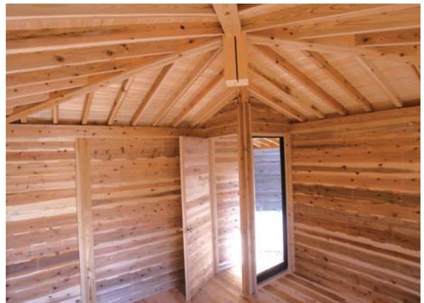
金物を使用しないスギ材を用いた高耐震板倉壁の完成
