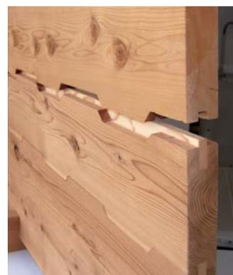
高耐震板倉壁構法は伝統的な木組みによる免震技術が取り入れられている
