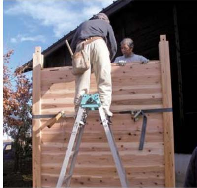
2人1組で壁1枚を20分で組み上げる。落とし込み板壁構法なので工事は手早い
