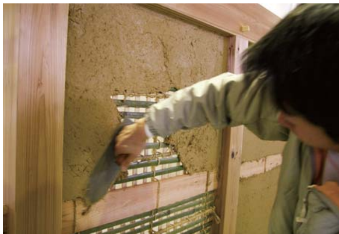
実大試験体を製作し、性能試験を行っている
