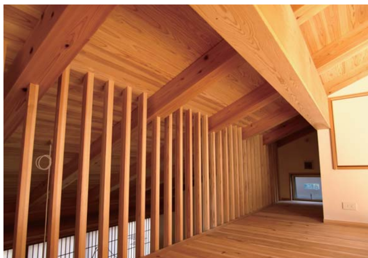
準防火地域内に建築した木造3階建て
