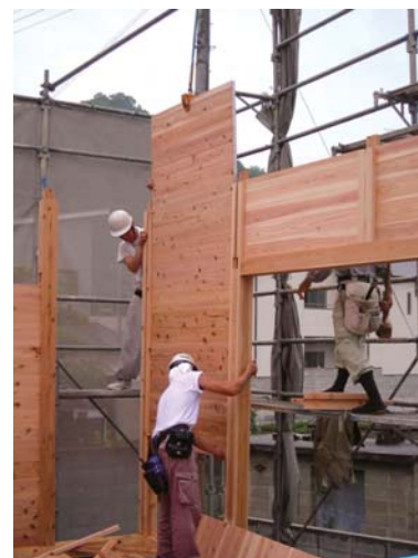
板を落とし込み壁を形成する
