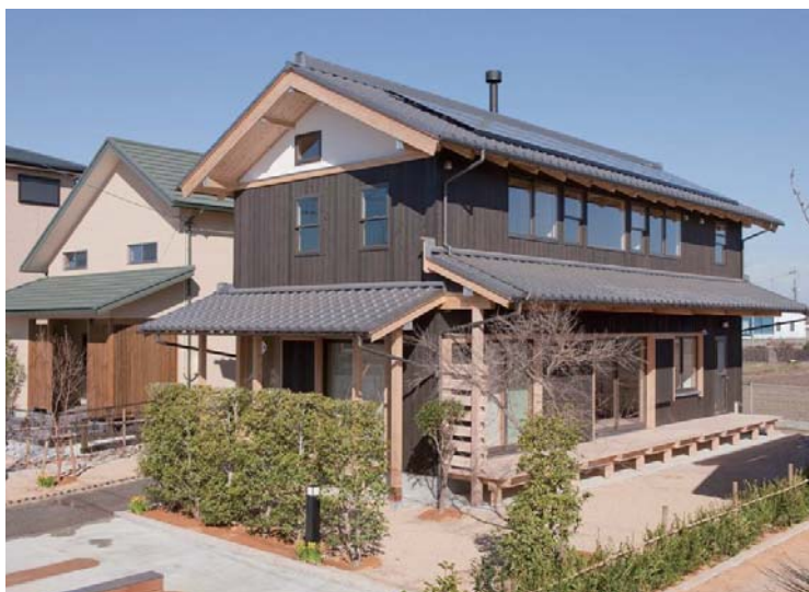
徳島県阿南市に建設された「板倉の家」ゆたか野モデルハウス
