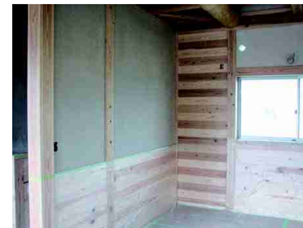
仕上げ工事を行うことなく、無垢材の積層パネルを現し仕上げにすることも可能
