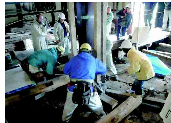
改修工事の様子。大黒柱の建て起こし作業
