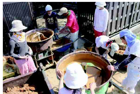
研修やワークショップでは、壁塗り作業だけでなく土壁の材料づくりも行っている
