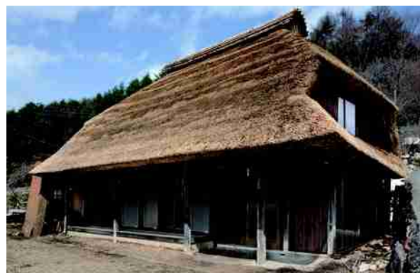
竣工した「田舎暮らしの生活スタイル提案型展示住宅」
