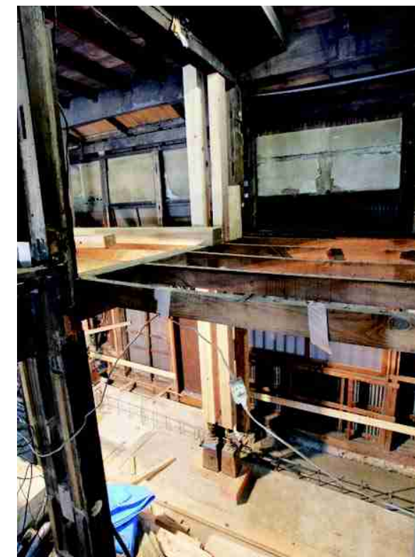
全体をスケルトン状態にし歪みを調整した後、通し柱も補強した
