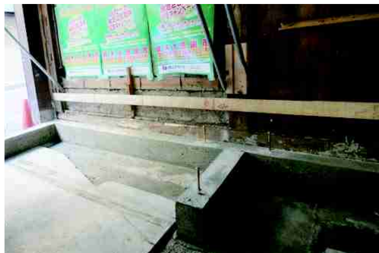
基礎を補強したところ（壁の劣化と加重対策のため）
