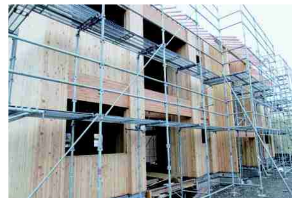
遠野市の市営住宅での施工の様子
