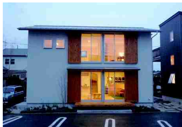
福岡県内に建設したモデルハウス
