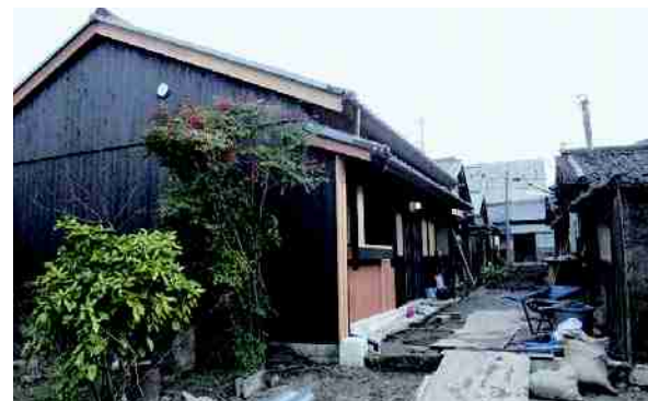
紀寺借家 完成外観
