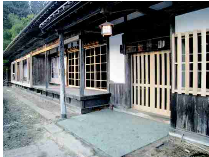
一関市山谷地区の古民家の改修
