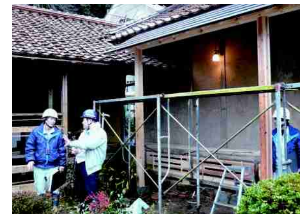
トイレの再生工事
