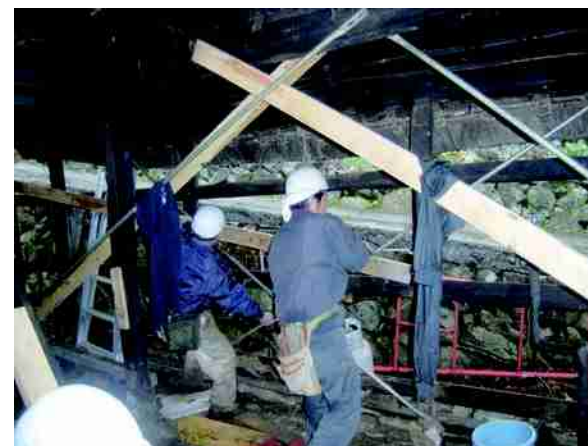
再生工事中で職人を育成していく
