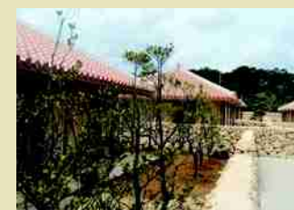
沖縄県宮古島に建てられた「金山杉住宅」
