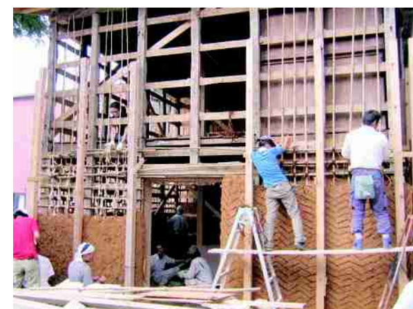
「塗り塀工法」により修復を実施、簡略化した小舞に団子状の土を付け、手で平らにしてい
