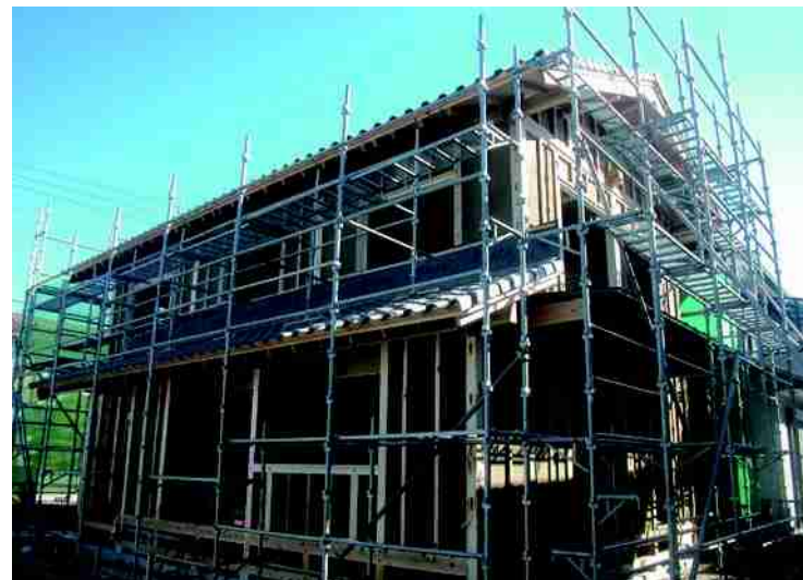
振動実験で損傷した伝統木造住宅を再生しモデルハウスとして公開
