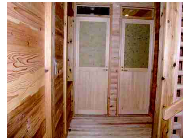
内壁・外壁としてささら板倉壁をあらわしで使用することもできる
