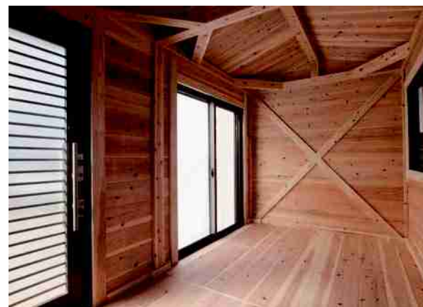
地域材を活用した木造のユニット（「板蔵」の内観）
