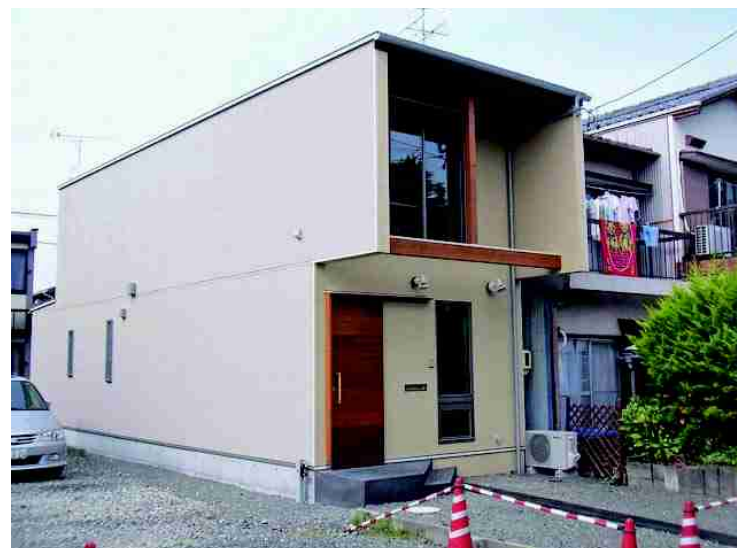
開発したたて枠材を使って実際に施工した住宅。施工検証を実施した
