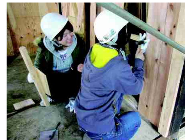
工事中の壁板張りイベント。一般の人に参加してもらった
