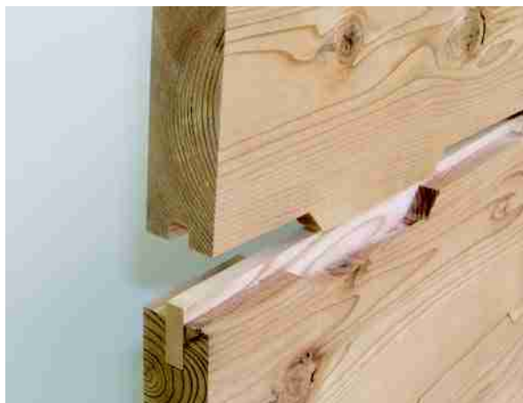
厚板同士を小さな板でつなぐ「雇い実継ぎ」により、反りや隙間の発生を防止する
