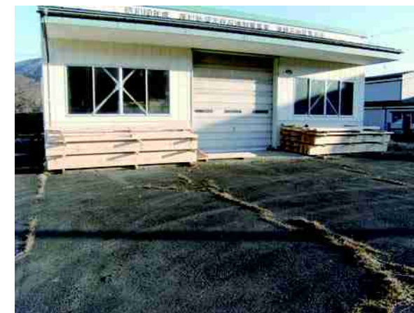
「南部アカマツ」を保管する「ストックヤード」
