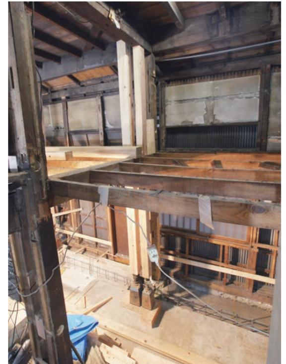
全体をスケルトン状態にし歪みを調整した後、通し柱も補強した
