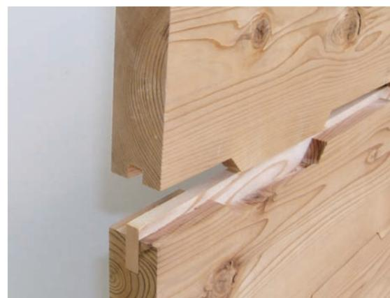
厚板同士を小さな板でつなぐ「雁い実継ぎ」により、反りや隙間の発生を防止する
