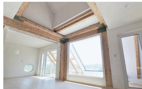
道産カラマツ集成材を用いた「J-耐震開口フレーム」のモデルハウス
