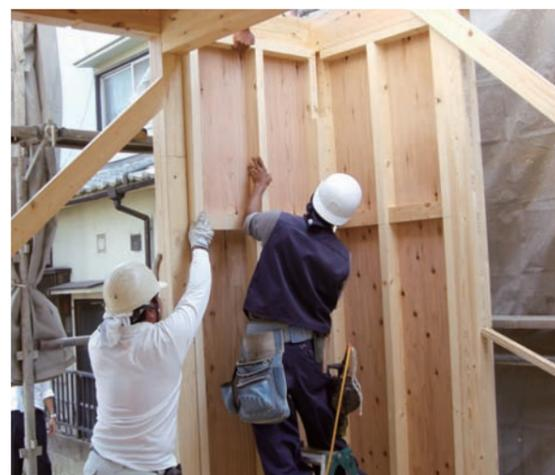
住宅の耐力面材として構造用合板の普及を図っている
