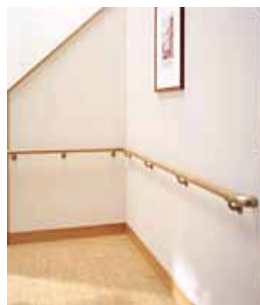
<手すりの設置>
