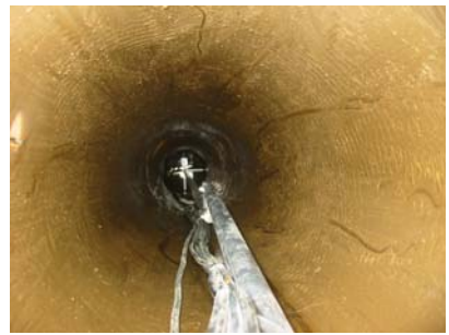
写真4 孔内の健全性試験装置
