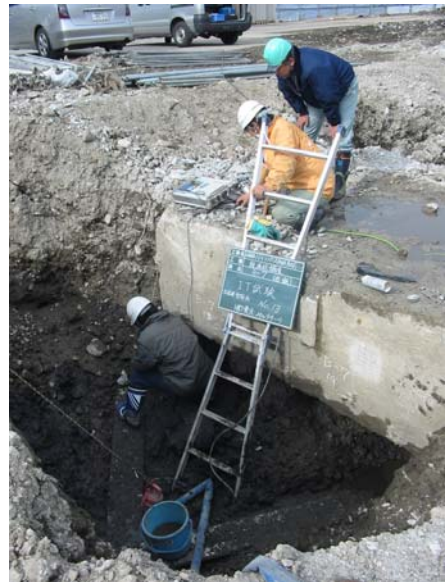
写真1 解体時に実施した調査例
