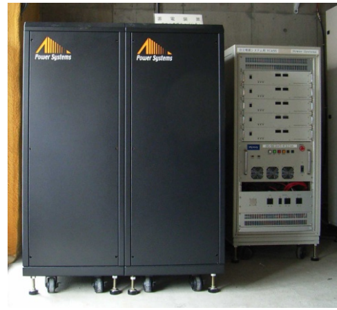
写真2 プロトタイプを構成するキャパシタバンク（蓄電容量2.7 kWh）
