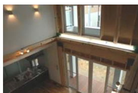
木質開口フレームの水平構面利用
