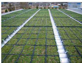
図 3. 折板屋根緑化システム「eco ヤネ」施工事例
