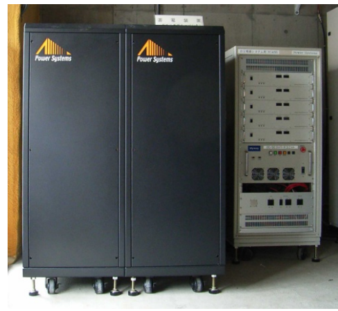
写真2 プロトタイプを構成するキャパシタバンク（蓄電容量2.7 kWh）
