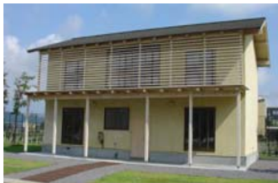
図3 木ダボ接合ラーメン構法による実験住宅
