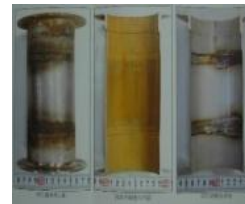
施工後23年経過の給水揚水管 (表面粗度 Ra=1.22μ)
