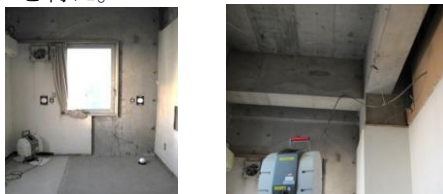
写真. 既存建物の様子 写真. 3次元スキャナー
