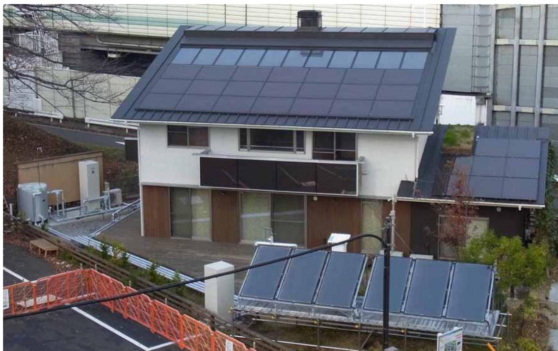
省エネ実証住宅
