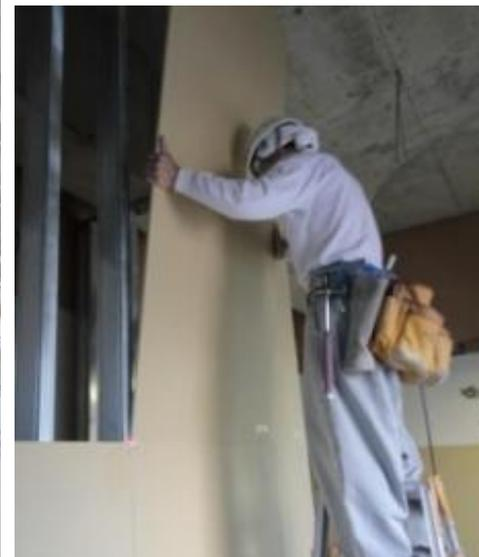
写真 軸材のレーザー光による位置決め
