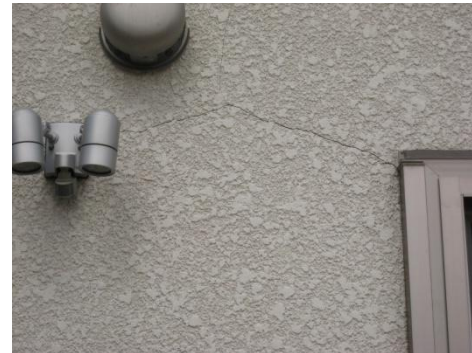
写真1: 外壁ひび割れ
