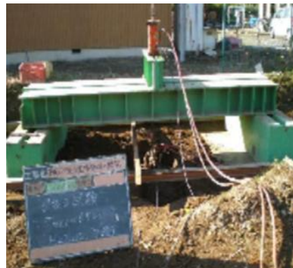
引き抜き試験
