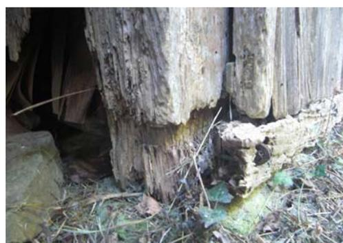
写真 3-2 腐朽菌による腐食
