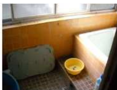
浴室改修 シャワー取付 着手前
