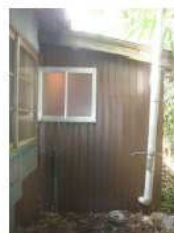
外壁改修 完了
