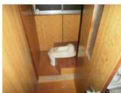
トイレ改修 着手前
