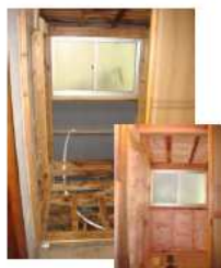
トイレ改修 解体完了
