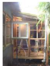
外壁改修 既存壁去除了
