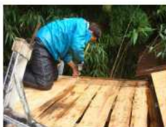
屋根漏水改修 断水合板張り
