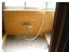
浴室改修 シャワー取付 完了
