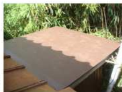
屋根漏水改修 完了
