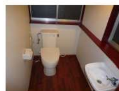
トイレ改修 完了
