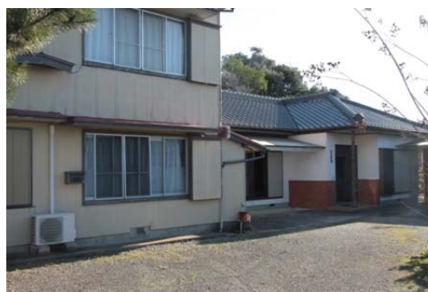
■「結いの家」として活用する空き家
