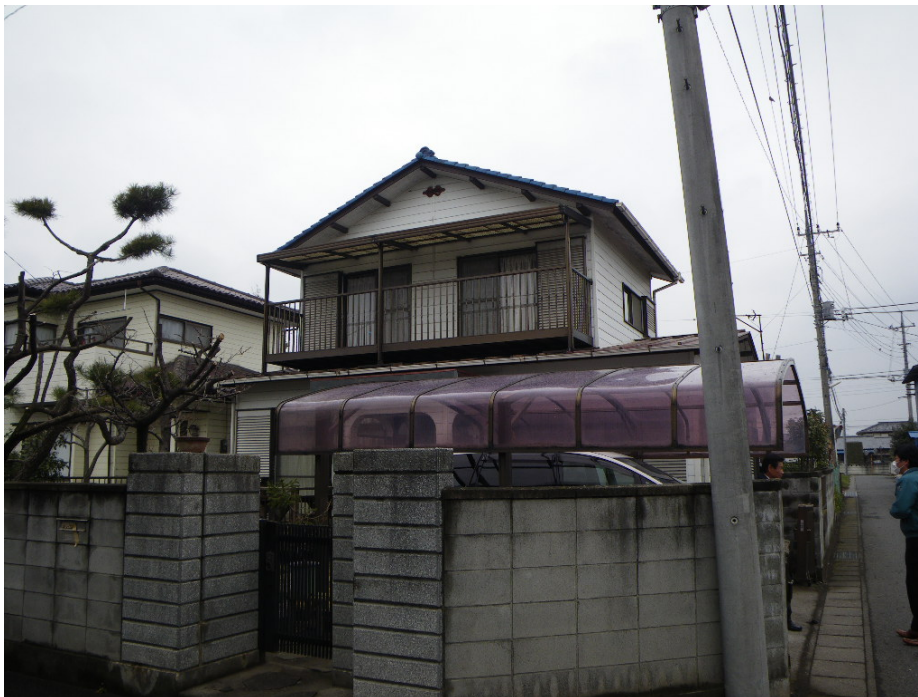
上の写真の中古物件を購入し大規模改修を行う
