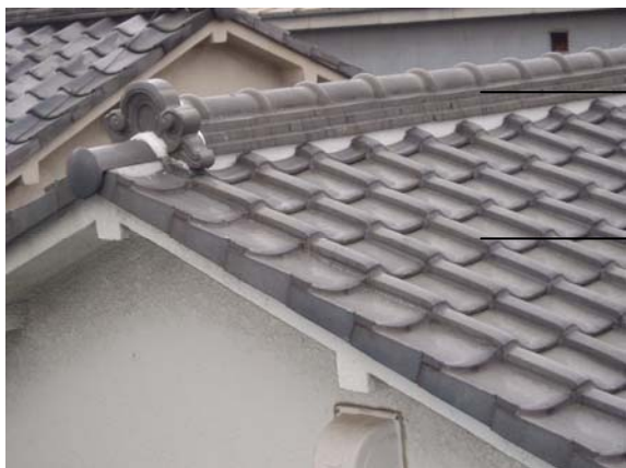
写真①：漆くい工事と瓦のコーキング処理 がされた屋根
