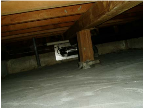
写真②：コンクリートの打設、換気扇の設置
