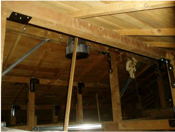
写真④：金物の取付、攪拌機の設置
