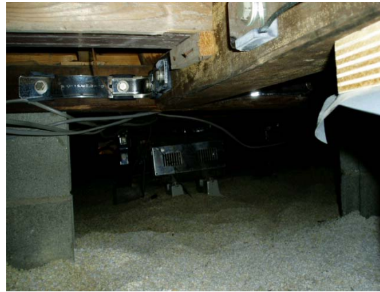
写真⑥：金物の取付、攪拌機の設置
