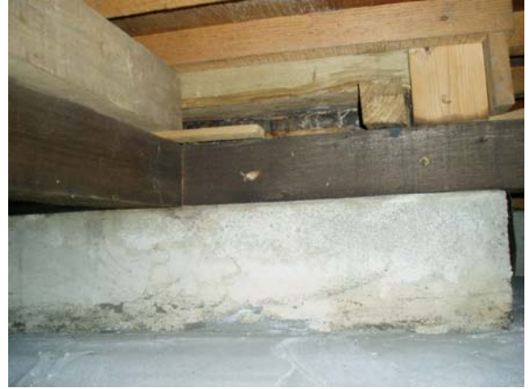
写真③：浴室下の土台。防腐剤を塗ったことで黒くなった木材を「黒カビが発生している」と業者は説明。
