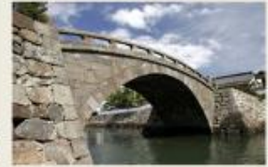
幸橋（オランダ橋）
