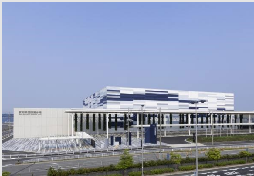
(対象施設の外観)
