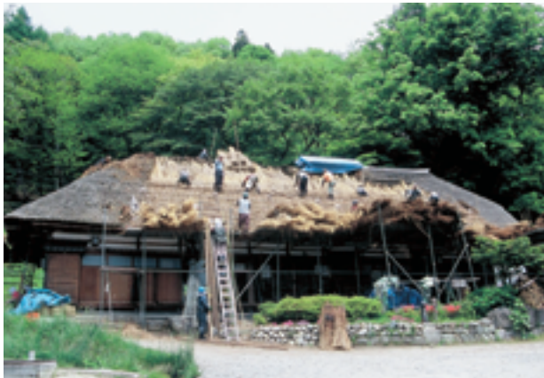
結いによる茅葺き屋根の葺き替え
