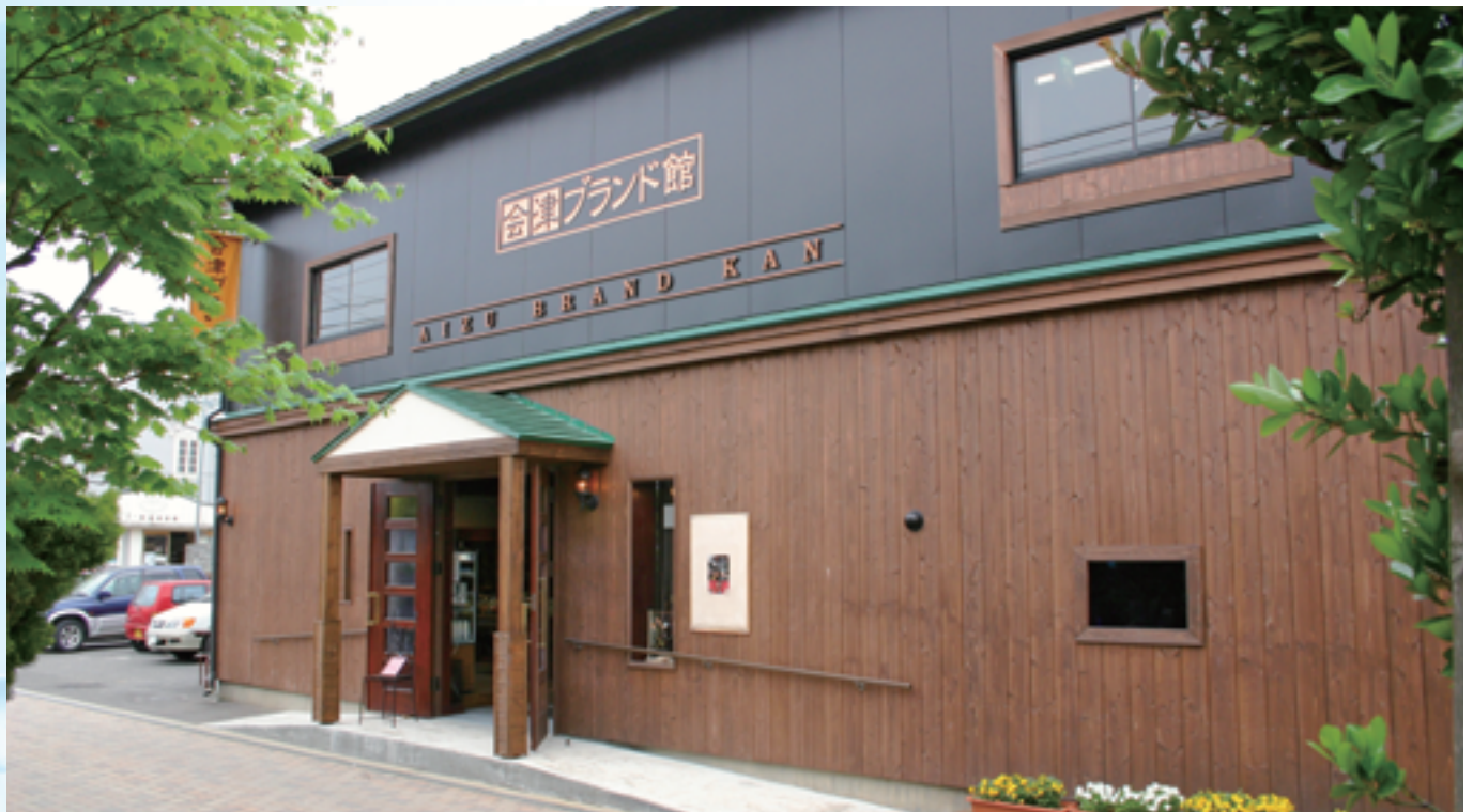
空き倉庫を改修した「会津ブランド館」
