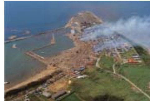
津波による被害 平成5年北海道南西沖地震津波による被害 (北海道奥尻町)
