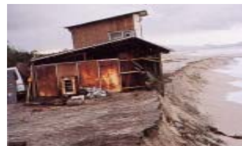
侵食による被害 冬季風浪による海岸侵食 (鳥取県皆生海岸)
