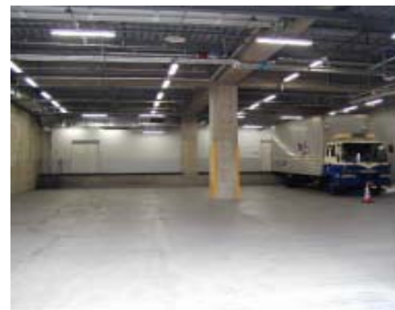
十分な高さとしきりの荷捌き場の設置された事例
