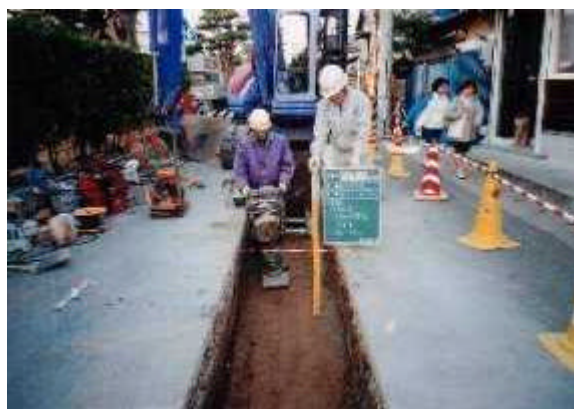
改良土の埋め戻し状況
