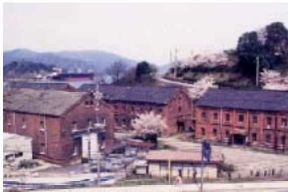
舞鶴湾岸に立ち並ぶ12棟の赤煉瓦建造物群。 うち8棟は毎夜ライトアップされる。
