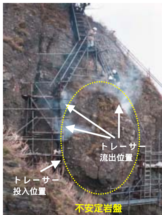
写真-2 トレーサーの流出状況
