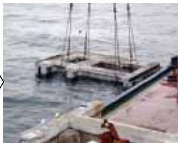
魚礁据付状況
