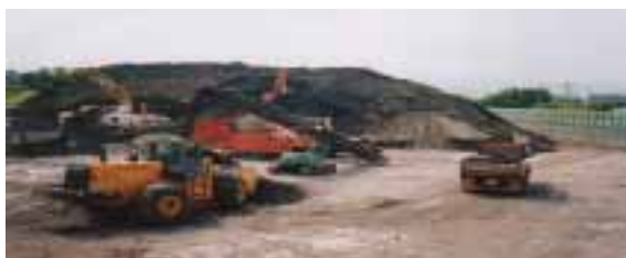
鋳物廃砂と移動式プラント
