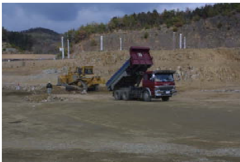
【県道路事業からの土砂搬入及び敷均し状況】
