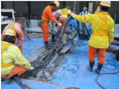
カットジャッキ工法
