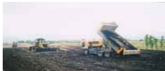
高速道路への盛土利用
