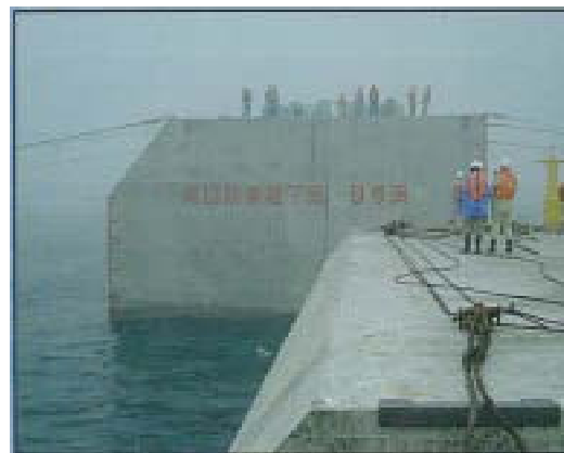
半没水上部斜面試験堤ケーソン据付状況
