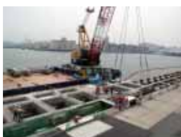
栈橋上部コンクリートの撤去状況
