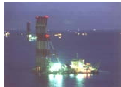
サンドドレン船による夜間工事
