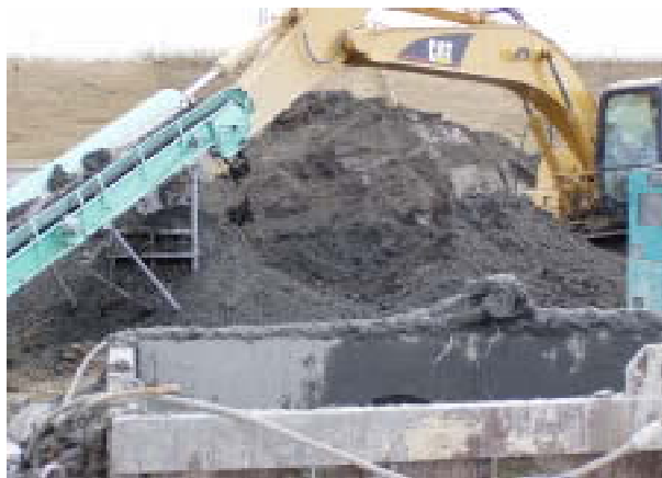
オデッサシステムによる改良土
