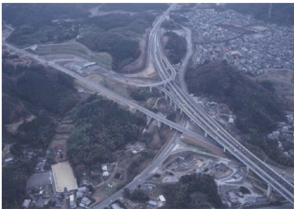
写真 東九州自動車道・宮河内インターチェンジ
