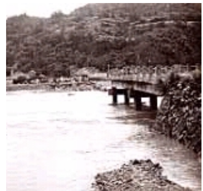
チリ津波による大浦橋の被害(1960年5月)
