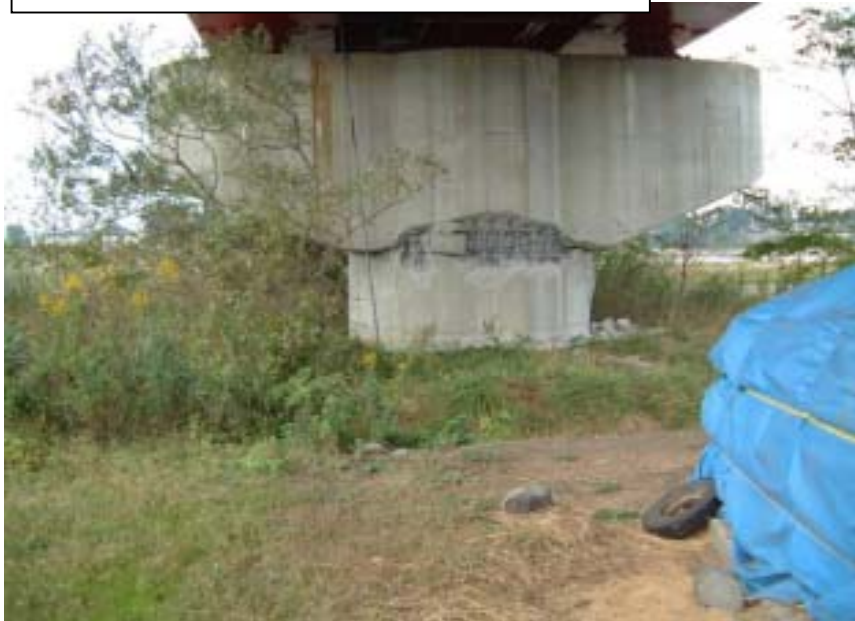
写真5-2:一般国道17号 小千谷大橋
