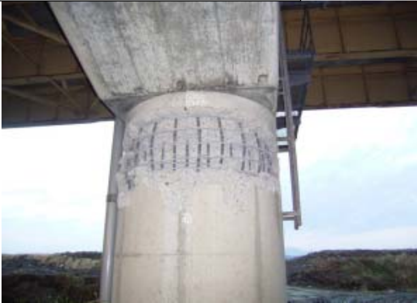
写真4-1:一般国道8号 新組高架橋
