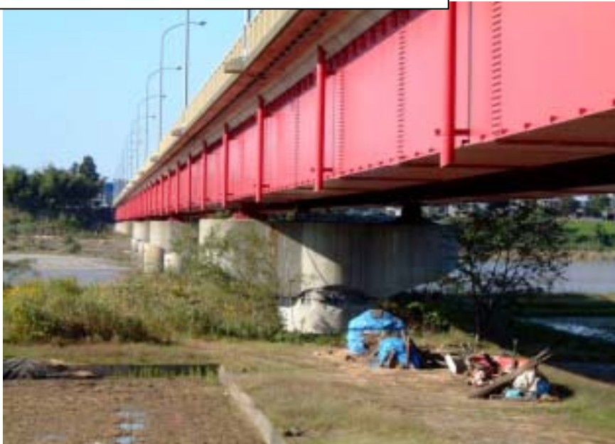
写真5-1:一般国道17号 小千谷大橋
