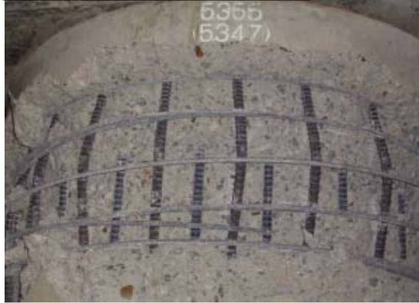
写真4-2:一般国道8号 新組高架橋
