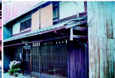
□改修前の側面
