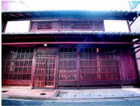
□改修後の正面
