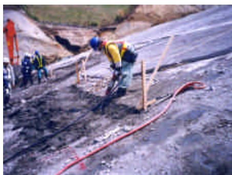
ピックハンマ人力掘削 従来工法
