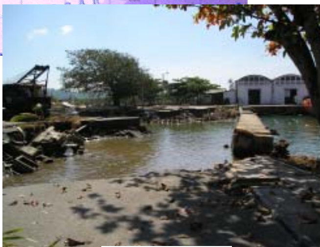
被災した岸壁 (ゴール港)
