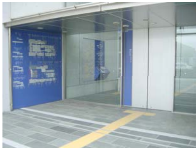
自動式引き戸、段差のない出入口
