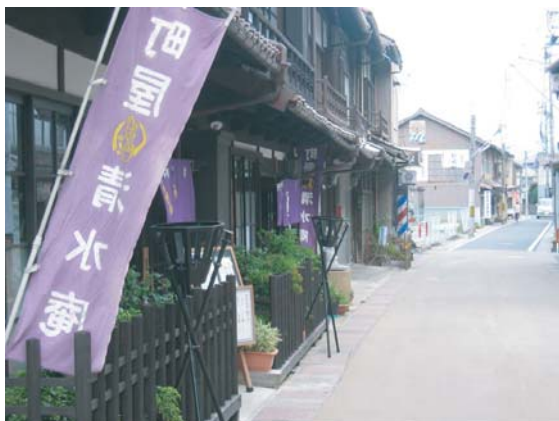
大正初期に米屋として建築された建物。倉吉の町屋に共通する平入り瓦葺き二階建てで、外観は質素な造りだが内部は素晴らしい。特に中の間に設けられた渡り廊下の空間構成に贅沢さを感じる。
