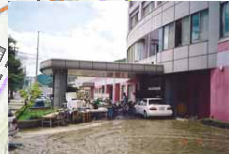
岩国市藤河地区 被害状況
